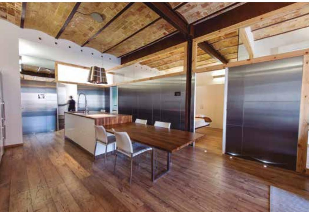
**Muros de carga de ladrillo macizo, pilares, vigas y viguetas metálicas reforzadas intensamente hace apenas una década.**
