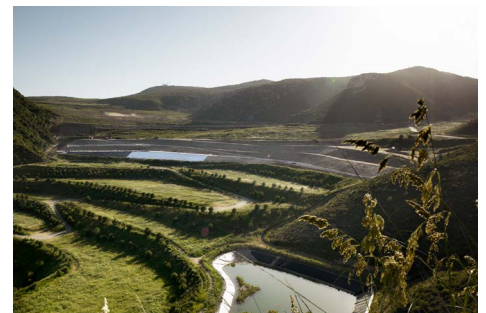
Restauración paisajística de un vertedero de residuos por Batlleiroig. Parque Natural del Garraf. © Jordi Surroca
